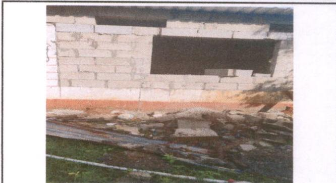
Foto 2: sustitución de muro de lamina por muro de block.
